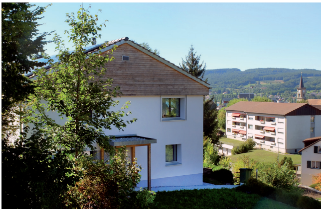
Dieses rund 60 Jahre alte Einfamilienhaus in Steckborn entspricht heute höchsten Effizienz- und Komfortansprüchen.
