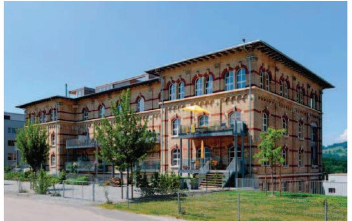
Bei der Sanierung wurde besonderes Augenmerk auf einen sorgfältigen Umgang mit der vorhandenen Struktur gelegt. Durch massvolle Reparaturarbeiten an den Aussenwänden konnten die denkmalpflegerischen Werte erhalten werden. Die zusätzlichen Balkone wurden als gestalterische Elemente integriert. Durch den Umbau sind grosszügige und lichtdurchflutete Loftwohnungen entstanden, die geprägt sind vom Industriecharakter des frühen 20. Jahrhunderts – eine durchwegs gelungene Umnutzung.
