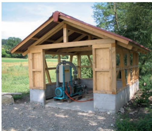
Mit Pumpen wird das Wasser aus einem Kleinsee gewonnen (z.B. am Hüttwilersee)
